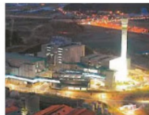
발전 설비 공사
