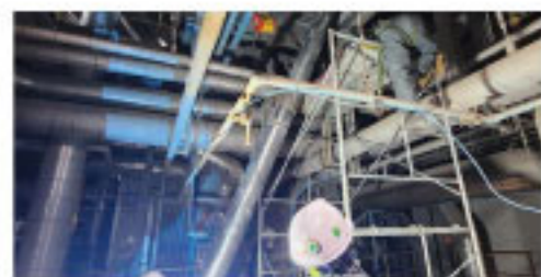
과열기재 배출컨베이어 이송라인 개선작업
