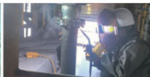
바닥재 배출컨베이어 1,2 슬라이드게이트 오버홀 작업
