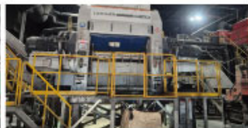
가연물분쇄기 연간계약 오버홀 공사
