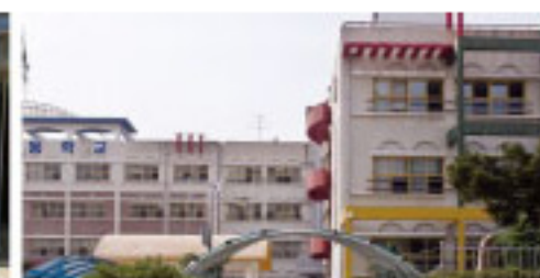
교육청 화장실 기계설비공사
