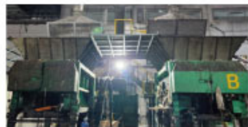
파분파쇄기 연간계약 오버홀 공사
