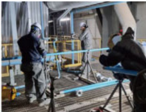
신규라인 배관 설치 공사
