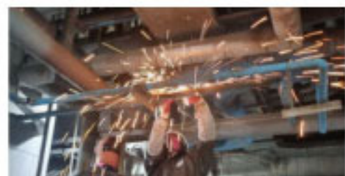
제 냉각계통 배관 LINE 교체 및 신규 배관설치작업
