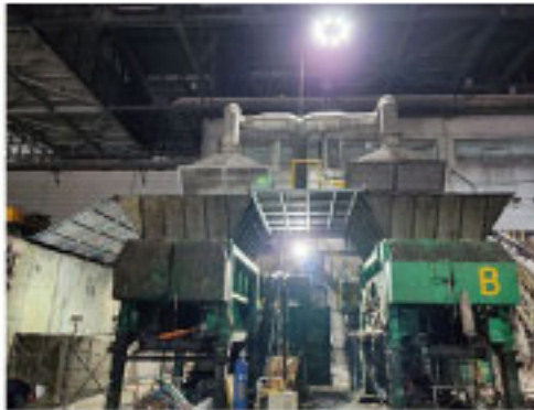
파봉파쇄기 (연간계약) 오버홀 공사
