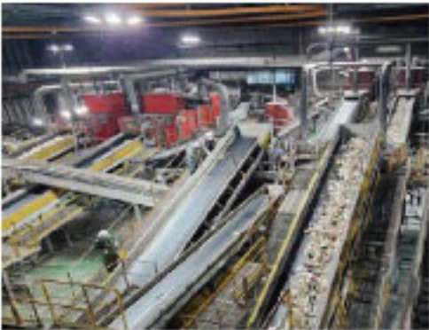
벨트 컨베이어 시공 및 연간 유지 보수 공사
