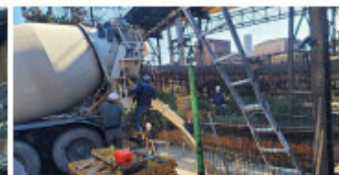
Sludge Box 매립 및 재설치 작업
