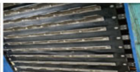
SRF 공급컨베이어 및 로터리밸브 오버홀 작업
