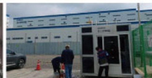
산소충진시설 작업대기실 설치
